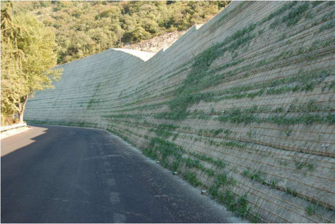
Ricostruzione e messa in sicurezza di versanti in frana con terre rinforzate
