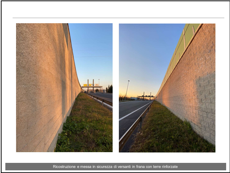
Ricostruzione e messa in sicurezza di versanti in frana con terre rinforzate
