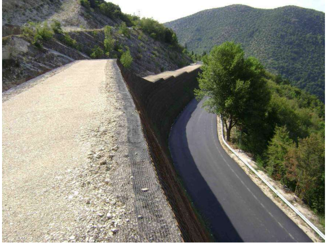
Ricostruzione e messa in sicurezza di versanti in frana con terre rinforzate
