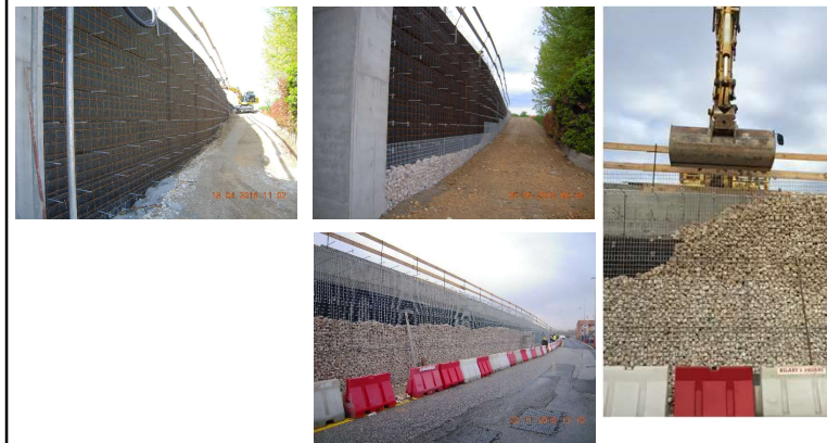
Ricostruzione e messa in sicurezza di versanti in frana con terre rinforzate
