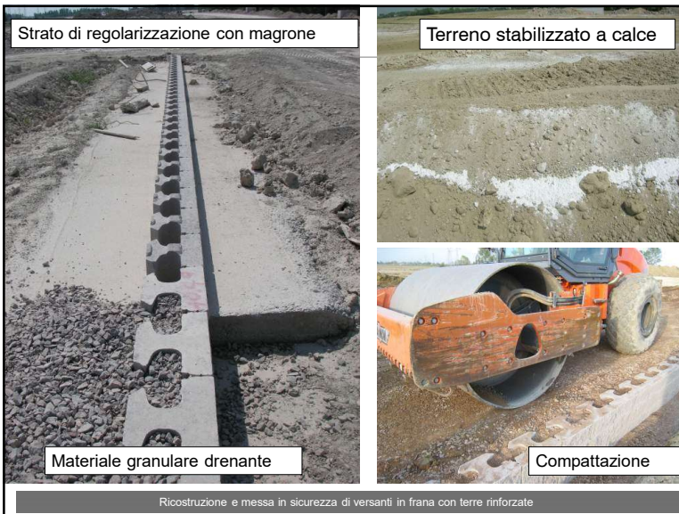
Ricostruzione e messa in sicurezza di versanti in frana con terre rinforzate
